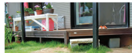
リサイクルベランダ&温室 神奈川県・村尾 哲郎さん 廃材で作ったベランダと廃棄されたサッシを使った温室で資源再利用。
